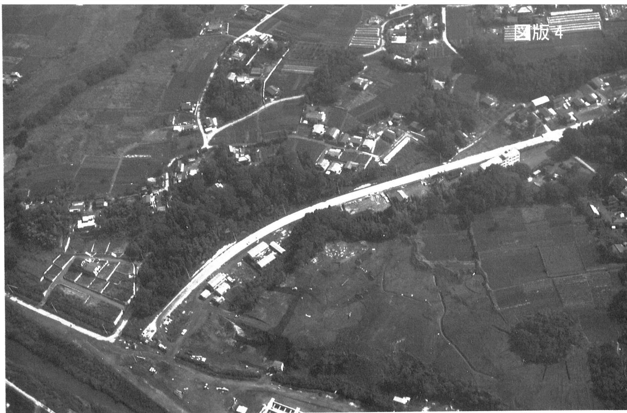
菊間手永遺跡から南東方向俯瞰
