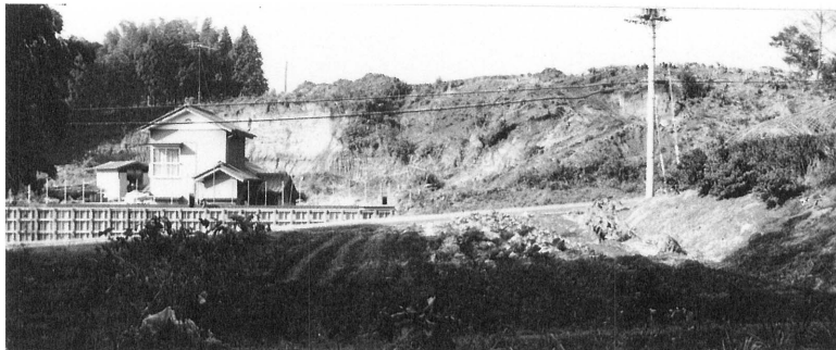
近景 北東側より
