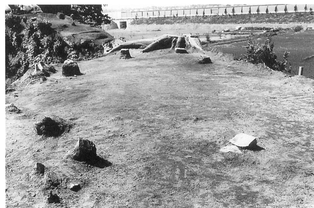
北側土塁の西端頂部の状況
