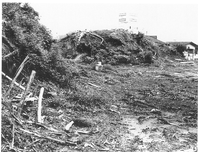
調査前の状況 南側より北側土塁を望む
