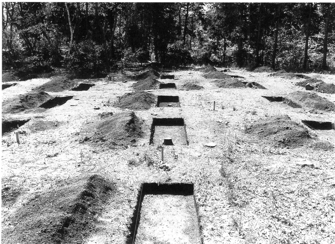
トレンチ設定状況（南側）
