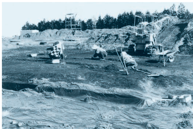
⑧表土除去に使用した小形ブルと作業風景
