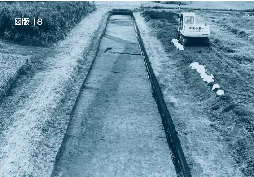
東側中央部分（北から）
