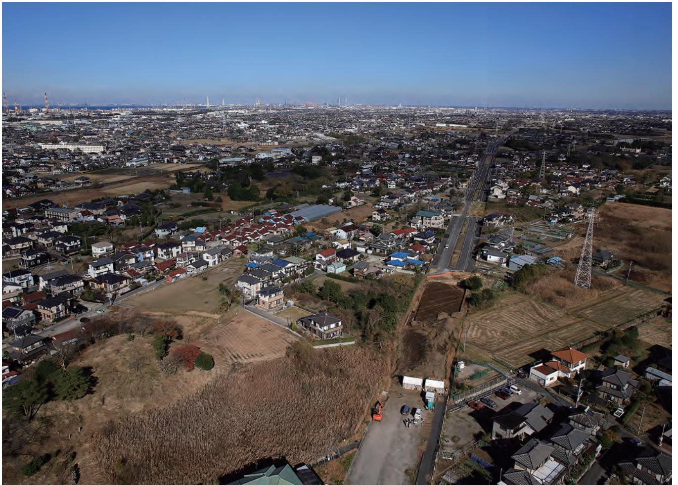
八幡椎津線(姉崎工区)遠景 南南西から
